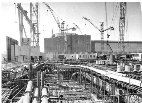
Строительство Балаковской АЭС
