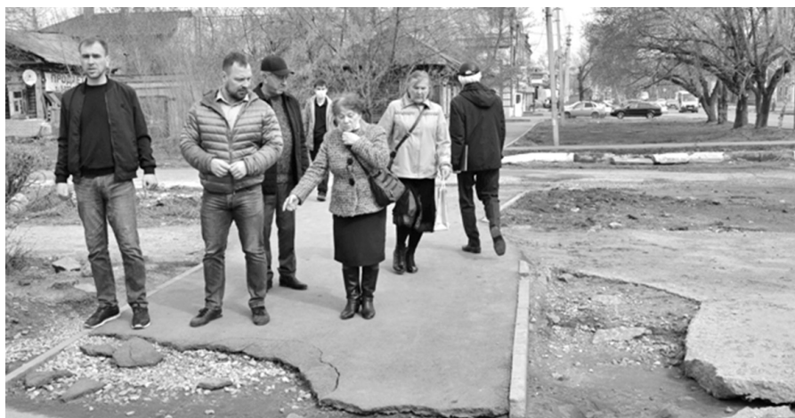
Вода сделала своё дело. Перекрёсток на ул. Бр. Захаровых и Ленина
