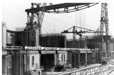
Монтаж здания ГЭС в зоне ГА 6-7
