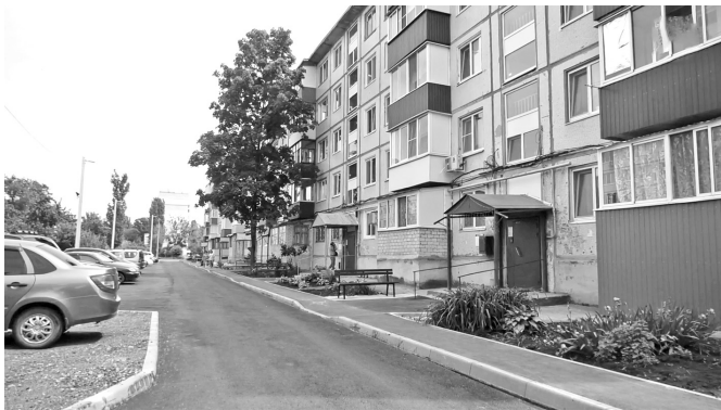
Ремонт на ул. Чапаева, 129
