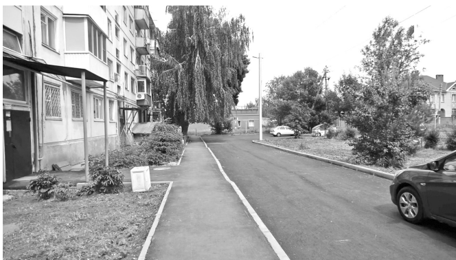
Ремонт на набережной Леонова, 44
