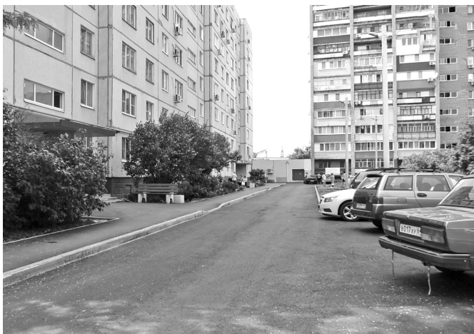
Ремонт на ул. Свердлова, 5
