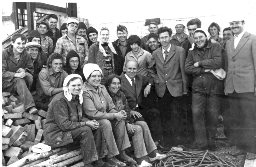
Насосная станция №17 (оросительный канал), 2 сентября 1976 года
